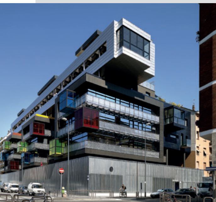
ATTICI DI VIA DOBERDÒ, MILANO
